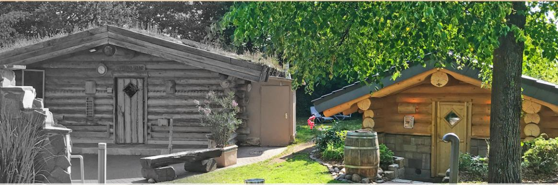
Lapland-Sauna Derzeit außer Betrieb, Neubau 2025
